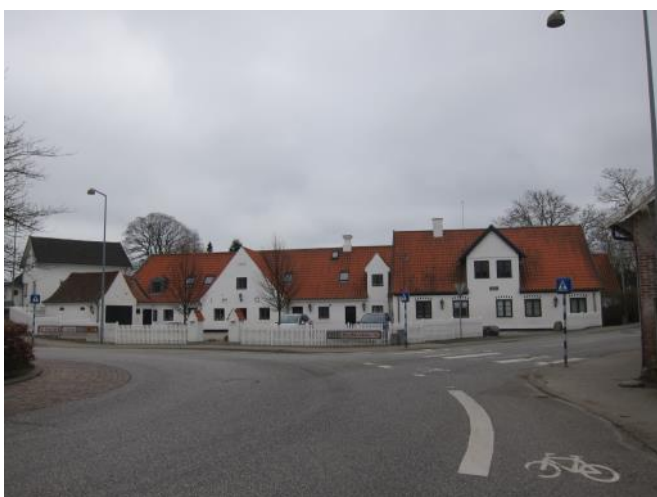
Den gamle lægebolig danner afgrænsning af rundkørslen mod syd og overgang til de bevarede dele af landsbyen.
